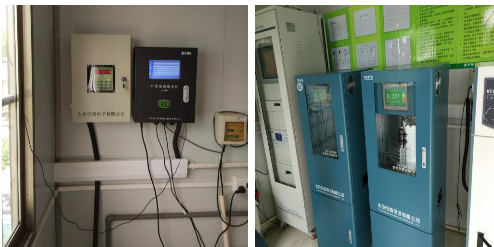
图 4 污水在线监控装置
