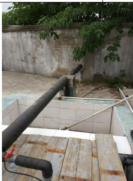
图 2 污水外接管道
